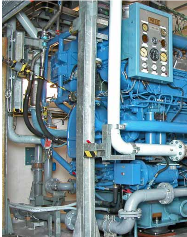
Diesलगeneraattoreiden uusiminen on Olkiluodon voimalaitoshistorian suurin yksittäinen muutostyö.
