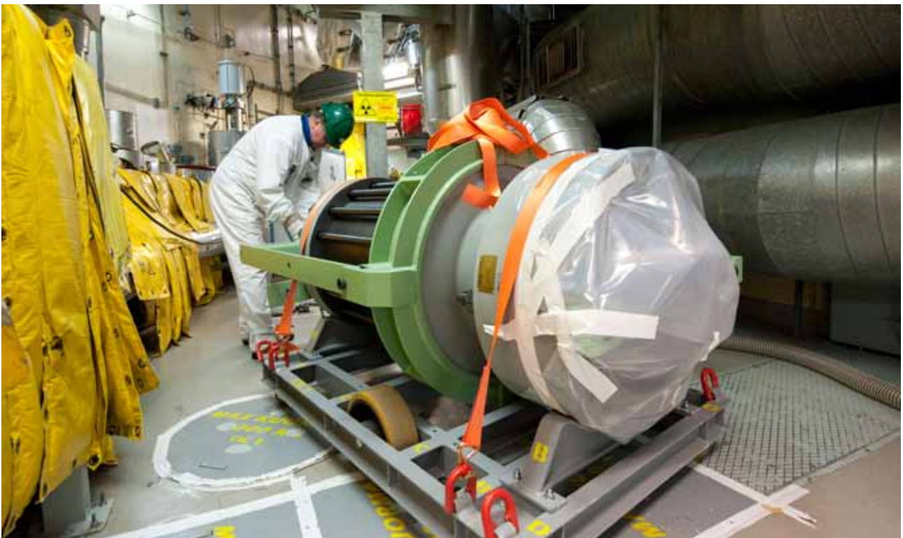
Olkiluodon voimalaitoksella säteilyltä suojautuminen on oleellinen osa kaikkea toimintaa. Vuosihuollossa säteilevän kohteen suojaus tehdään esimerkiksi lyijymatoilla.
